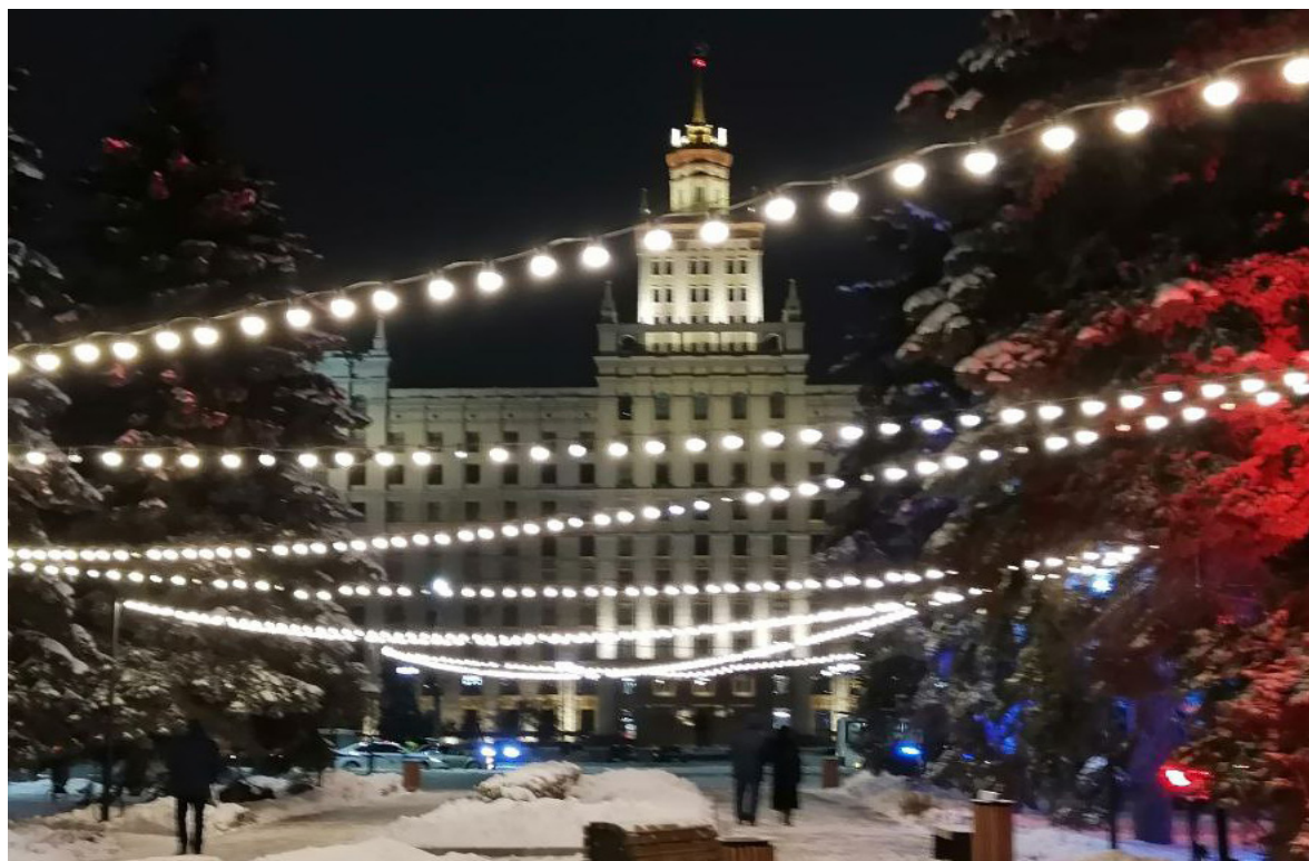
Рис. 7. Световая архитектура при визуальном восприятии с центральной аллеи сквера напротив главного корпуса ЮУрГУ
