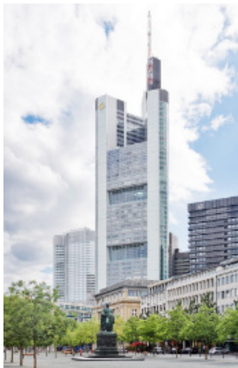
Рис.3. Общий вид здания Commerzbank (1997 год, Германия)
