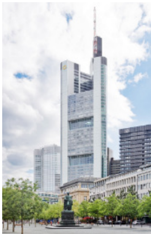
Рис.3. Общий вид здания Commerzbank (1997 год, Германия)
