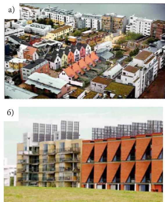
Рис. 5. Жилой комплекс Vo01: а – общий вид комплекса, б – общий вид жилых зданий с фотоэлектрическими системами
