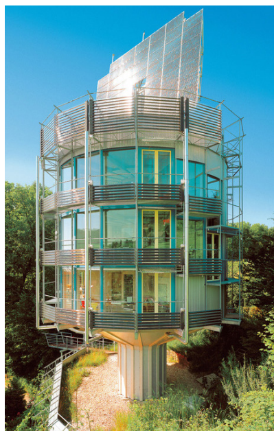
Рис. 2. Общий вид первого в мире здания, производящего энергию сверх потребления – жилой дом «Гелиотроп», арх. Р. Диш (г. Фрайбург, Германия)
