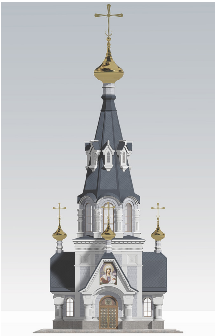
Рис.3. Главный фасад часовни
