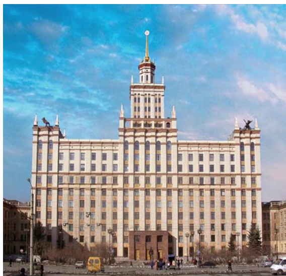
Рис. 4. Южный фасад главного корпуса университета после реконструкции. Фото с натуры. 2004 г.
